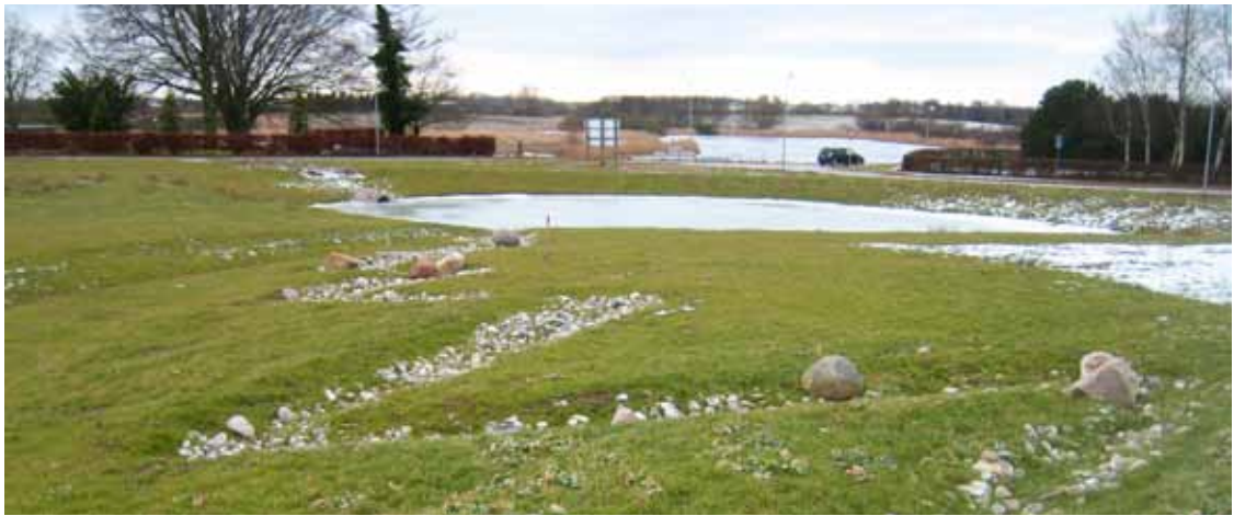
Sø til opsamling af regnvand fra Holmehøj ud mod Piledyssen og Østrupvej
